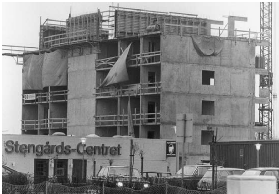
Jerne forandrede sig, da det stort boligbyggeri satte ind fra slutningen af 1950'erne og de næste 20 år. Boligblokkene på Stengårdsvej afsluttede byggeriet i selve Jerne, men fortsatte i Kvaglund. Billedet viser opførelsen af Stengårdscentret i 1973. (Foto: Tonny Sørensen. EBA 55717)
